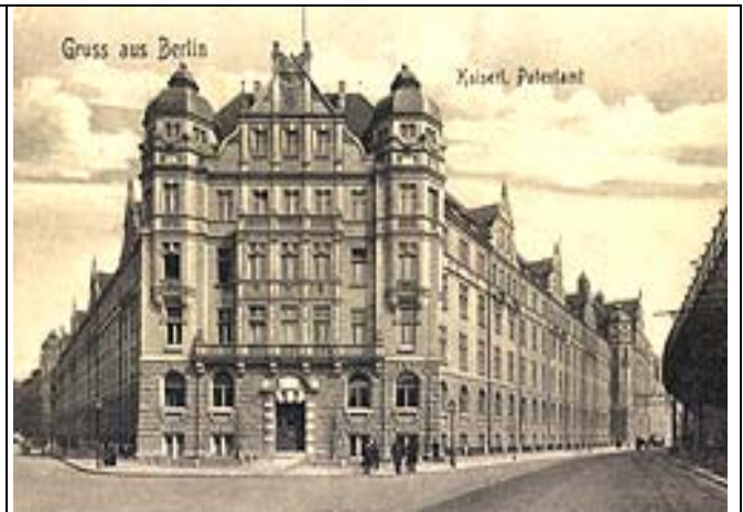
Das Kaiserliche Patentamt (heute: Europäisches Patentamt Berlin) nach Plänen des Architekten August Busse zwischen 1887 und 1891 errichtet.
